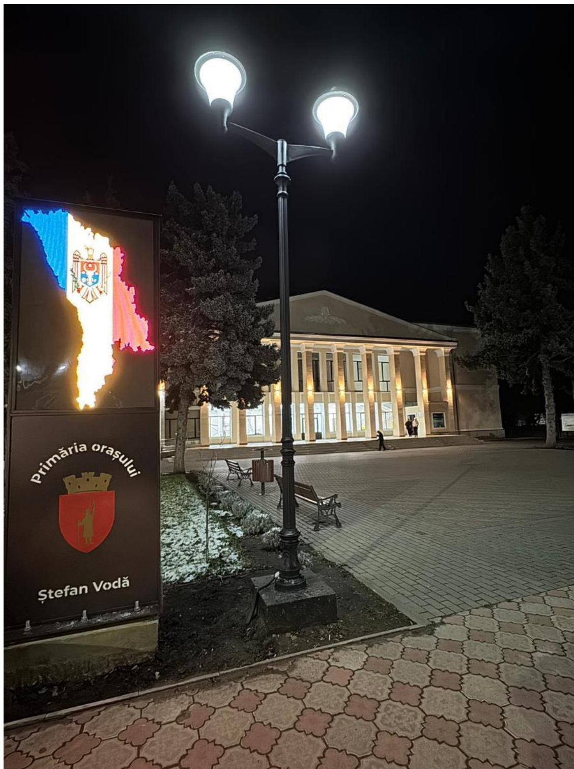
Fig. 6 Iluminatul public în Ștefan Vodă
